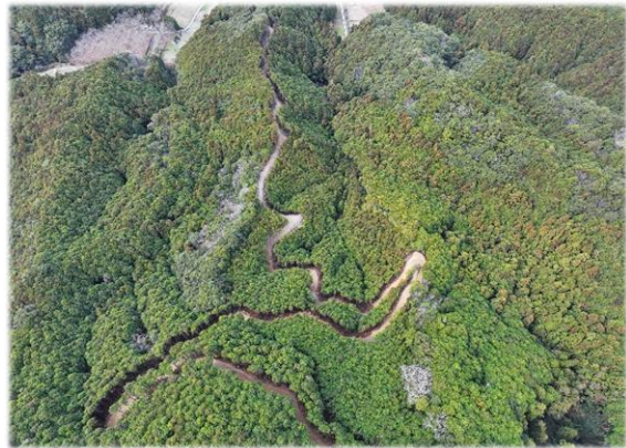
(上ノ土居地区で開設した森林作業道)
