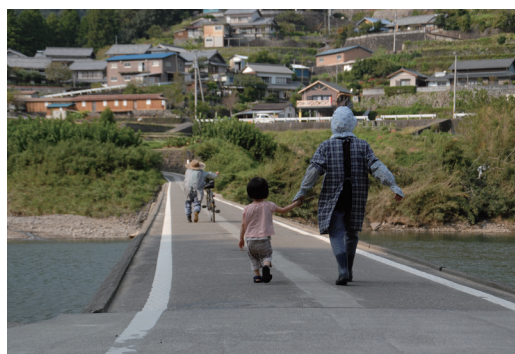
生活道として重要な橋
