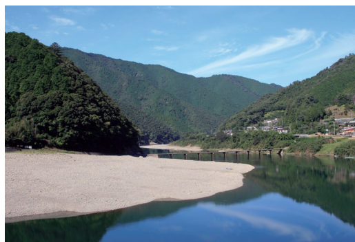
岩間の沈下橋（西土佐岩間）
