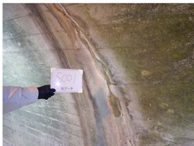
起点側坑口部（S001）の横断ひび割れ
