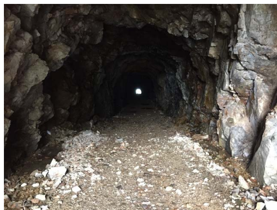
トンネル内状況
