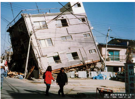
阪神・淡路大震災（住家被害の様子） 出典：一般財団法人消防防災科学センター
