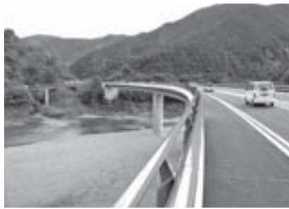
2月に開通した国道441号網代バイパス
